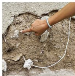
Unter dem Putz wird die Bauweise, bei der Lehm mit Stroh versetzt wird, sichtbar.
